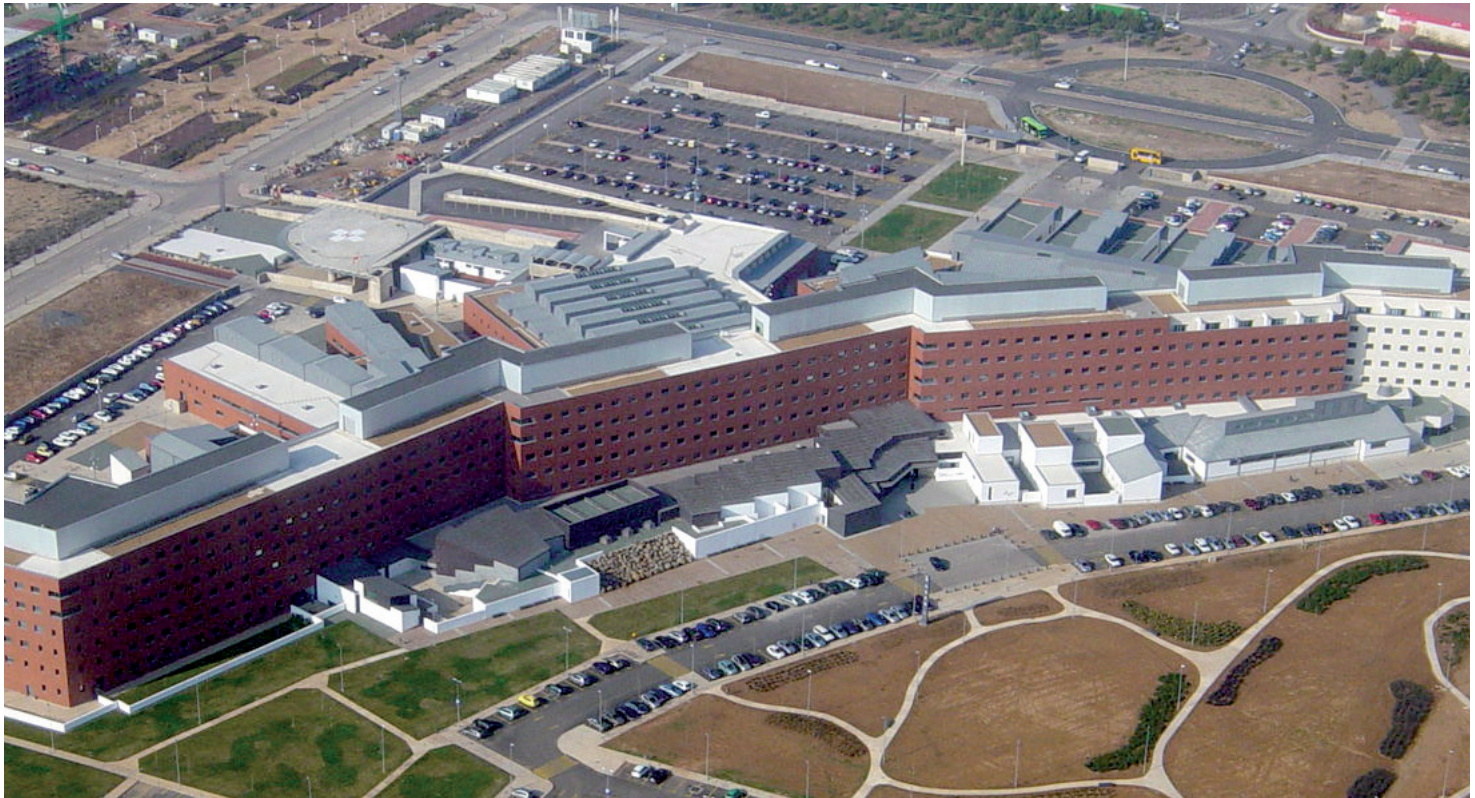
Hospital General de Ciudad Real
